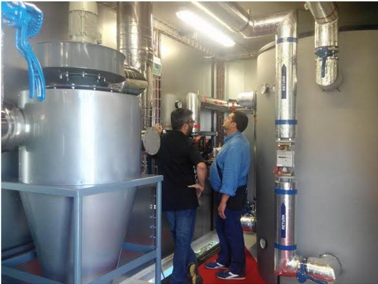
Las calderas de biomasa Smart Heating, cuyo distribuidor para España y Portugal, Smart Heating Ibérica, está en Asturias, son una solución económica y ecológica para sistemas de calefacción y agua caliente sanitaria con un intervalo de potencia que va desde los 250 kW a los 500 kW.
